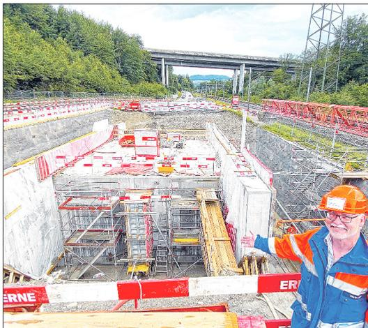
«Das ist das 1200-Tonnen-Betont-Element, das am Wochenende vom Freitag, 23. Juli bis am Montag, 26. Juli, unter die SBB-Gleise geschoben wird», sagt Projektleiter Martin Strübi vom Kanton und zeigt auf die Baugrube in der Aarauerstrasse, wo das tierische Teil mittlerweile fertiggestellt worden ist (Bild rechts).
